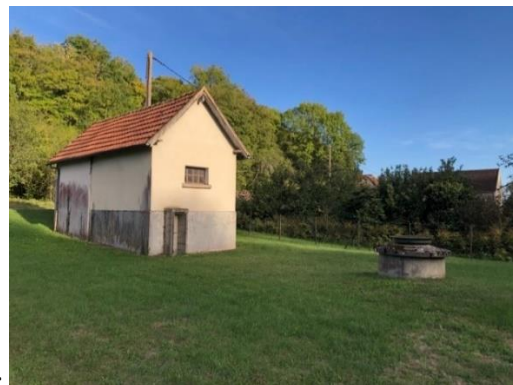
Le puits et le bâtiment comprenant les deux stations :
